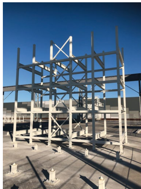
Bild 13 Unbeladene Deckenstapelgestelle Slab storage system
