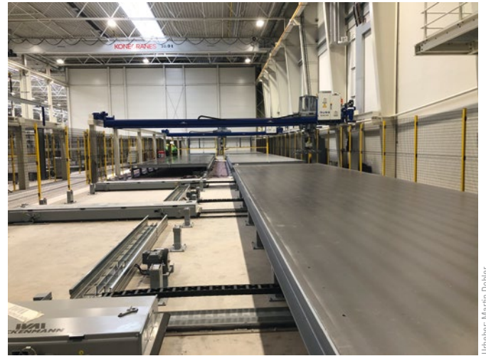
Bild 7 Paletten in der Produktionsanlage, Rollenböcke, Reibräder und Querhubwagen Pallets within production plant with conveyor system
