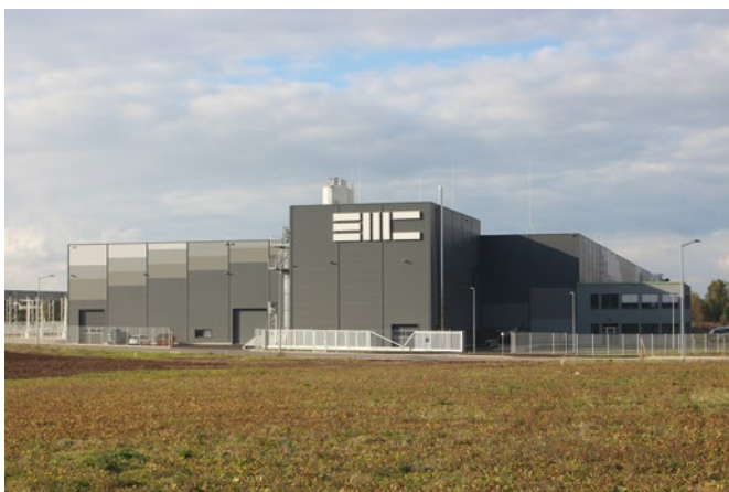
Bild 1 Fertigteilwerk südlich von Erfurt Precast plant south of Erfurt
