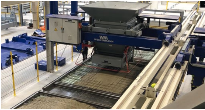
Bild 11 Betonverteiler bringt den Beton vollautomatisch in die Schalung ein Automatic concrete distributor
